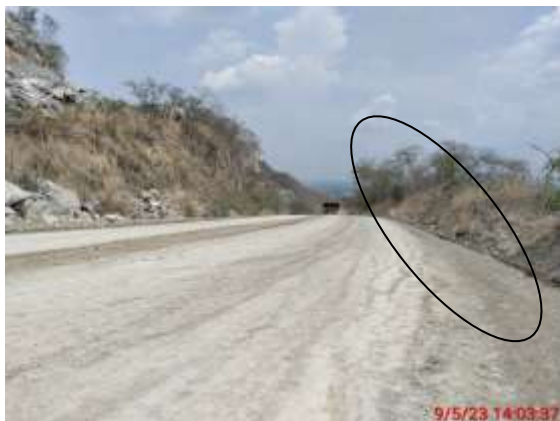
รูปที่ 16 ร่องระบายน้ำตลอดแนวเส้นทางขนส่งแร่
