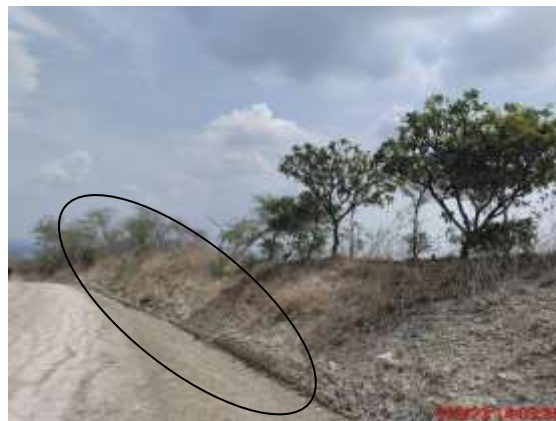
รูปที่ 16 ร่องระบายน้ำตลอดแนวเส้นทางขนส่งแร่
